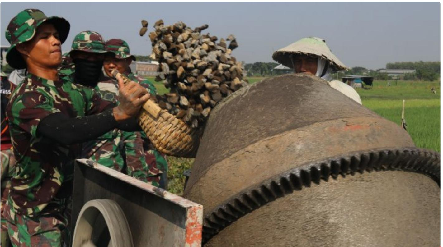
*(Foto istimewa ) personil satgas tmmd masukan material pengecoran jalan*
