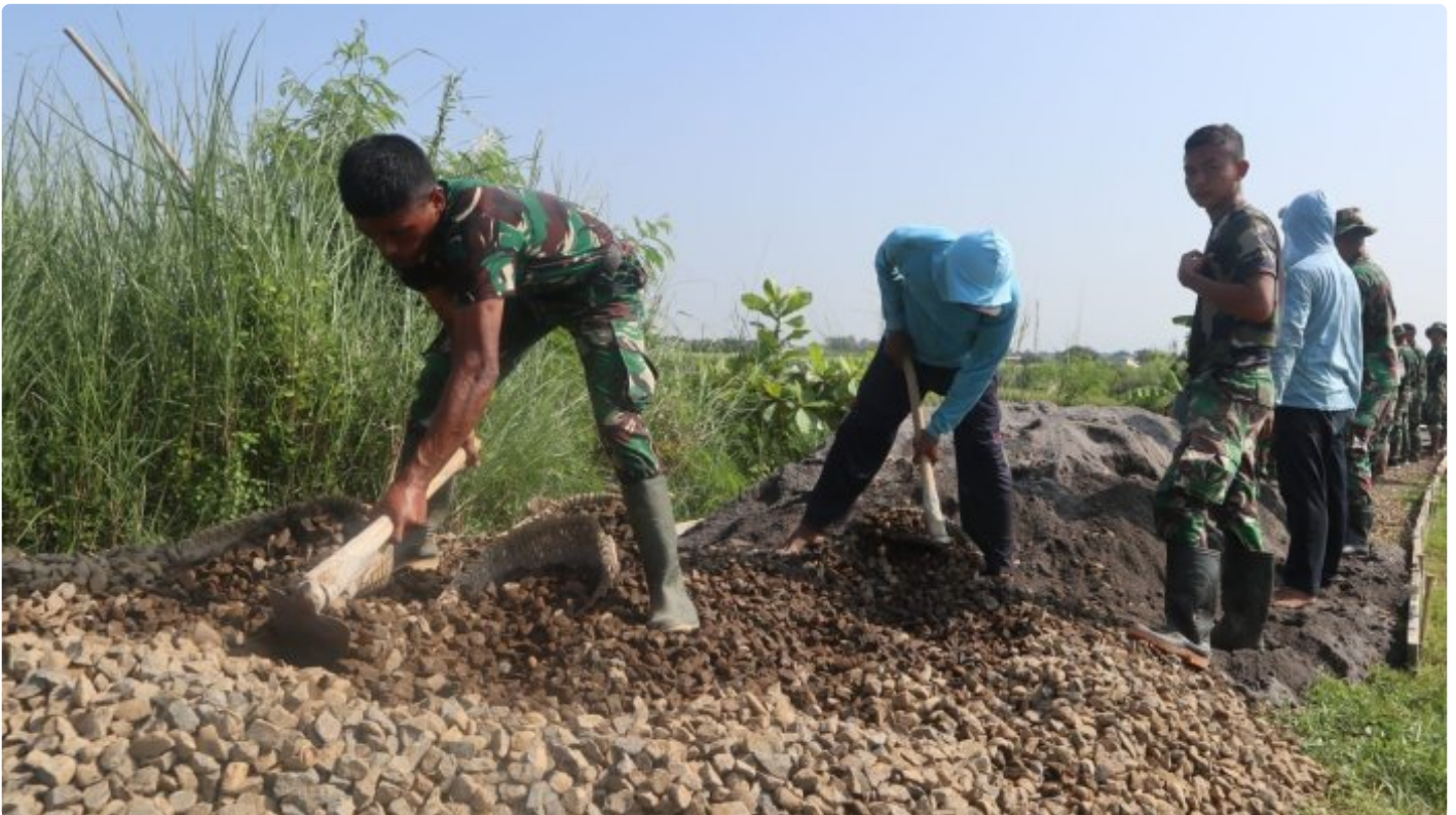
(Foto istimewa) Pengecoran Sasaran Fisik TMMMD 116 Kodim 0722/Kudus
