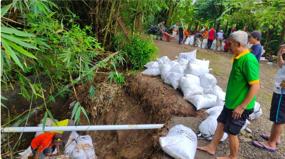
Dengan cara memancang bambu dan memasukkan tanah ke dalam karung untuk kemudian di tumpuk di bagian yang longsor sepanjang kurang lebih 3 Meter, lebar 2 Meter dan kedalaman 2 Meter ini dipimpin langsung oleh Kades.
